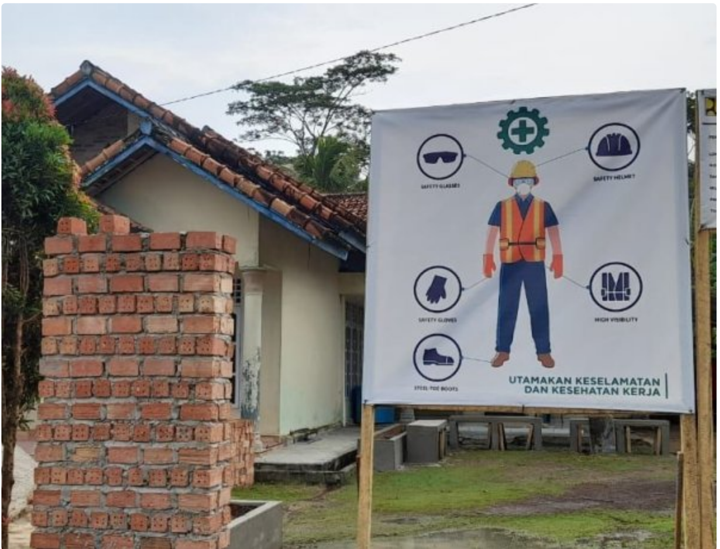
Proyek Infrastruktur Hunian Hijau di Mesuji
